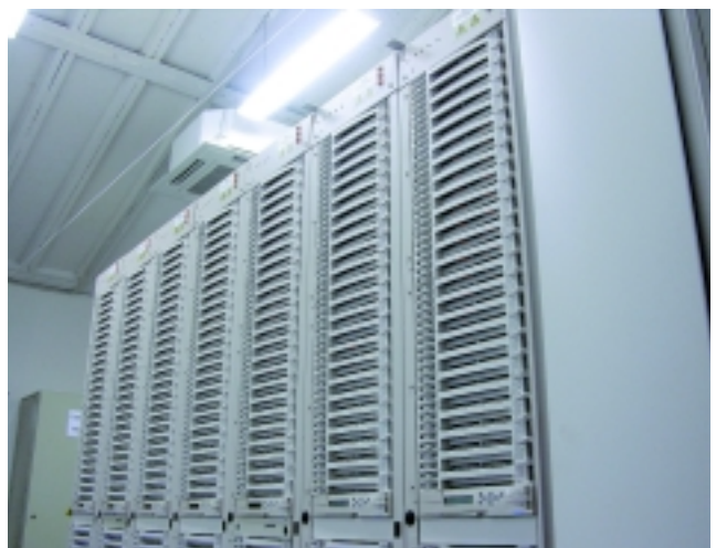
Диммерная станция ETC Sensor Advance с управлением и мониторингом по сети Ethernet
